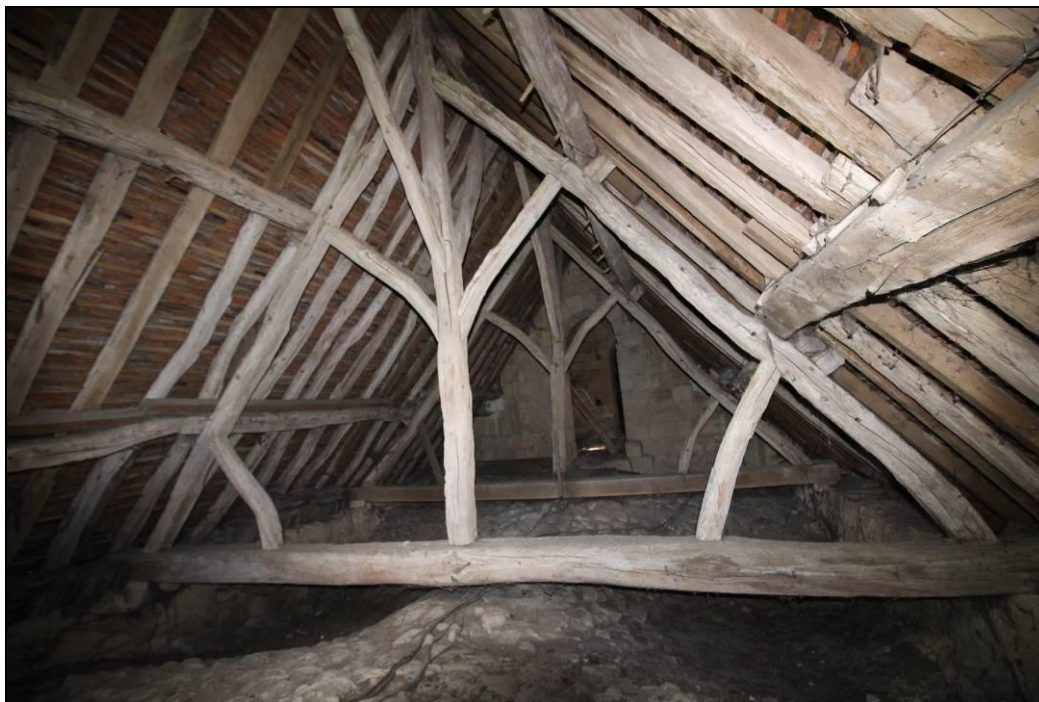
Charpente de la nef
