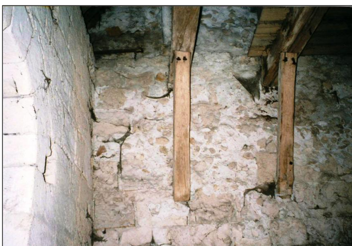
Mur Sud sous le beffroi : jambes de force rapportées (c)
