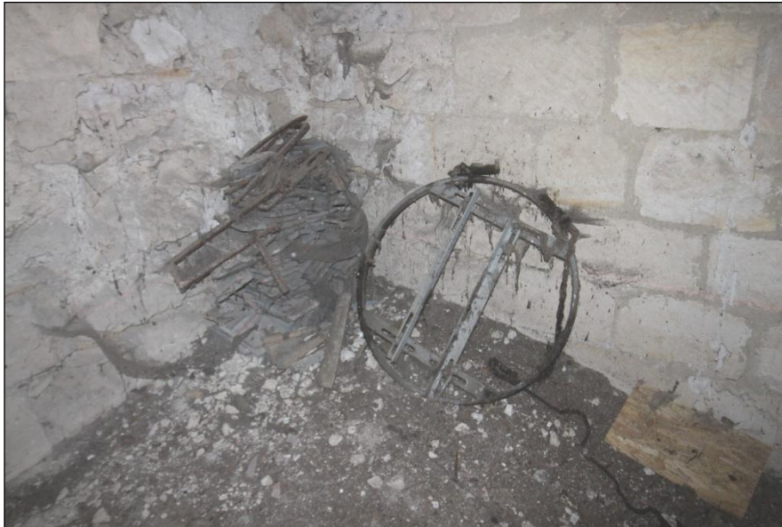
La roue de sonnerie posée au sol au niveau intermédiaire du clocher. Photo CG 2018.
