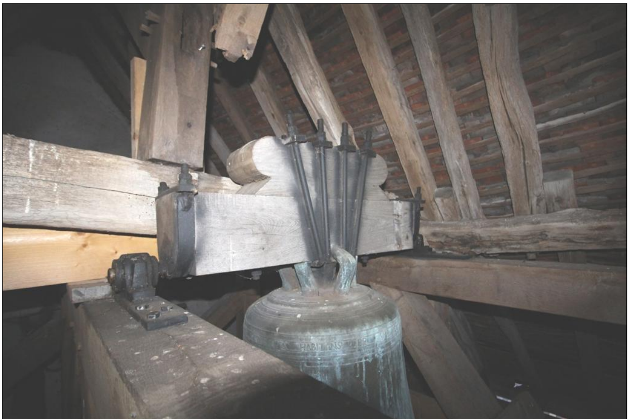
Effondrement du versant. Photo CG 2018.
