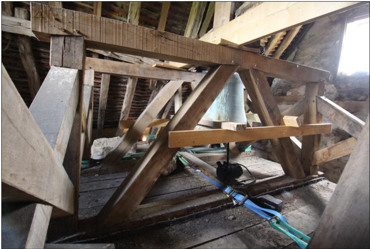
Mise en place dès 2017 : une sangle reliant les deux arbalétriers en lieu et place de l'entrait ; blocage de la cloche.
