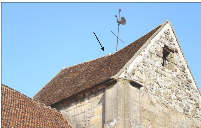
Vu du côté Sud-Ouest : faitage en V. Le mât portant croix, coq et paratonnerre penche vers l'Est, comme la ferme et le faitage. Photo CG août 2018.
