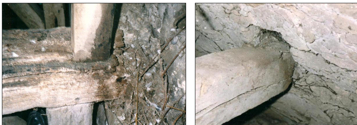
Photos avant travaux (dossier mairie). Détail des encastremements, chapeau Sud de la ferme centrale (b) et jambe de force (c).
