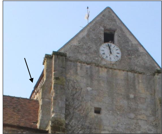
Détail d'une photo de mars 2014 : le parement a commencé à déverser.
