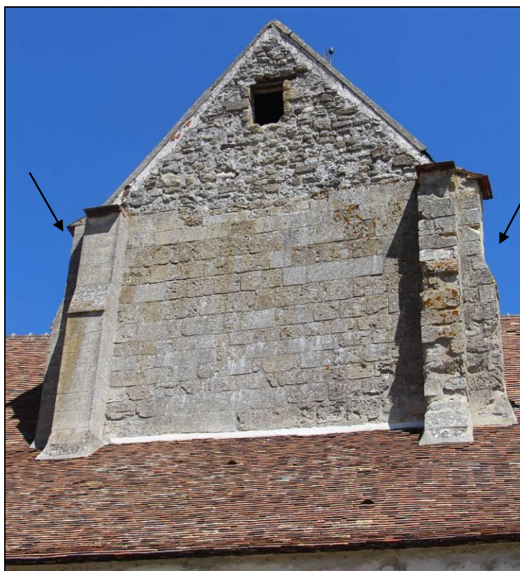
Face Sud du clocher
