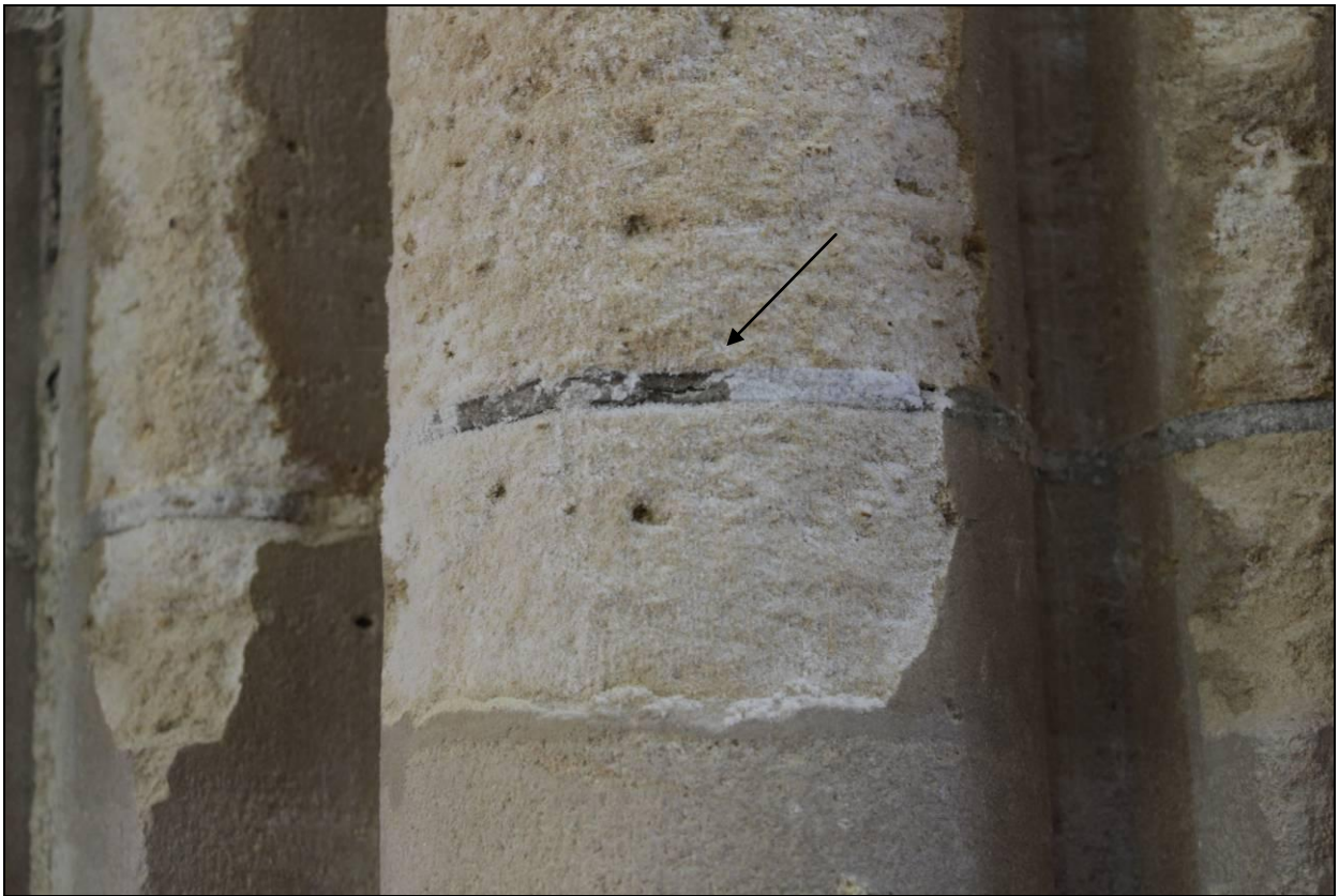
Détail d'une pile Nord : joint en ciment, parement désquamé
