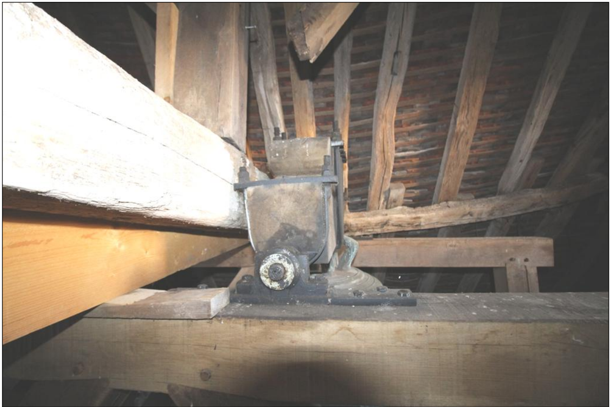
Le mouton positionné en 2004 contre la ferme centrale du toit. Photo CG 2018.
