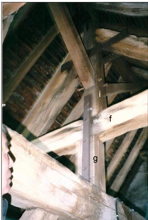
Ferme centrale du toit: poinçon, entrait retroussé (f), potelet (g) en appui sur la ferme centrale du beffroi. Renforts par fers plats en équerre, fixés à l'entrait, au poinçon et sur le dessus du chapeau.
