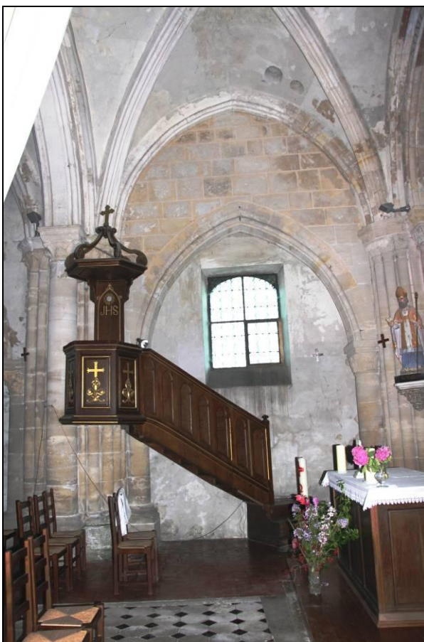
Parement intérieur de la nef, travée 1
