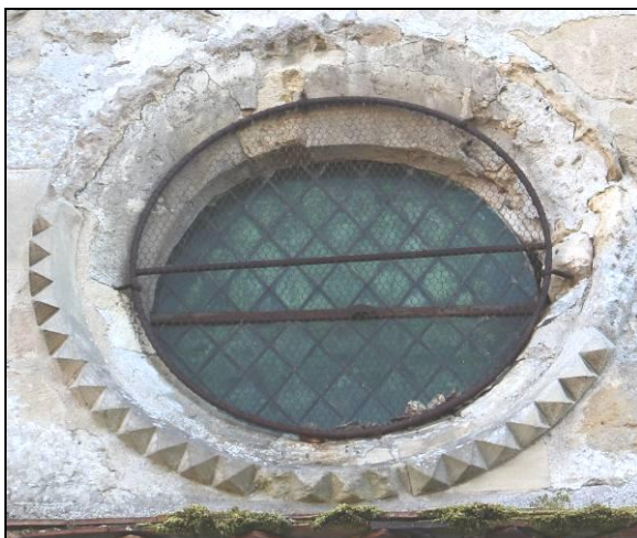
Baies haute de la nef, au Nord : n°105
