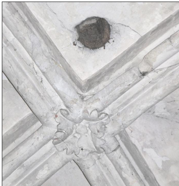
Détail du passage de corde, manchon en bois. Photo CG 2018.
