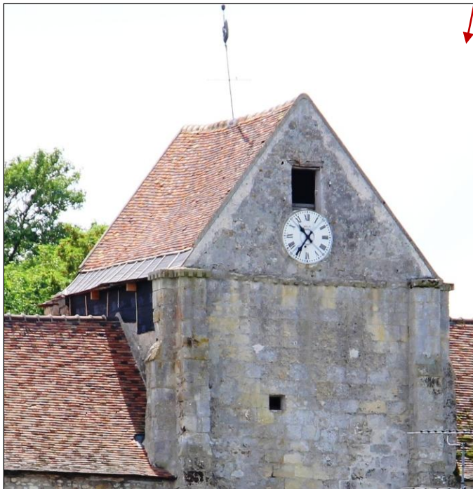
Détail: affaissement du faitage et du versant en leur milieu, parement pierre et égout tuiles déposés | Blocs stockés dans l'église.
