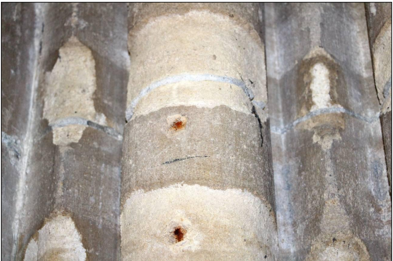
Détail d'une pile Nord : joint en ciment, parement désquamé
