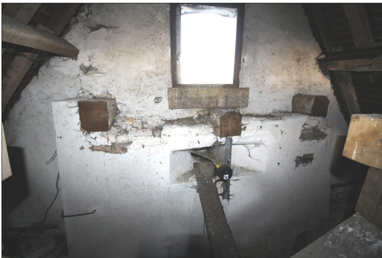
Mur-pignon Nord, en 2018. Les abouts sciés des chapeaux des fermes de l'ancien beffroi. Au centre du pignon, les fermes prenaient appui sur une partie de mur deux fois plus épaisse. Idem côté Sud. Ces abouts côté Nord n'étaient pas pourris.
