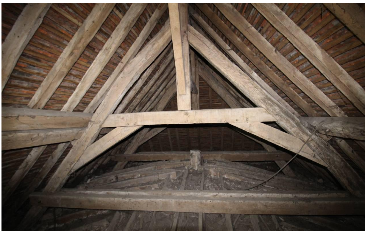
Charpente du chœur
